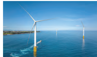
入善洋上風力発電所
