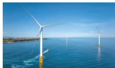
入善洋上風力発電所
