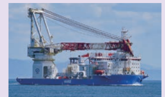
SEP船(建造中の3隻目)
