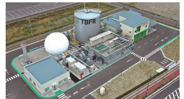
（株）東北バイオフードリサイクルプラント外観
