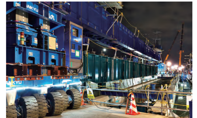
夜間における橋桁架け替えの様子
