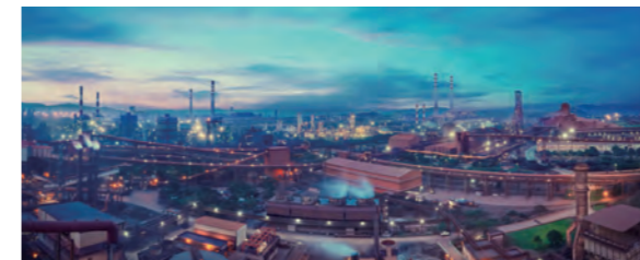
JSWスチール社のビジャナガール製鉄所
