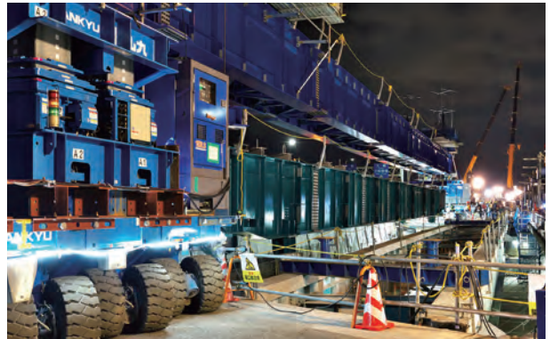
夜間における橋桁架け替えの様子
