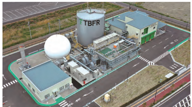
(株)東北バイオワードリサイクルプラント外観
