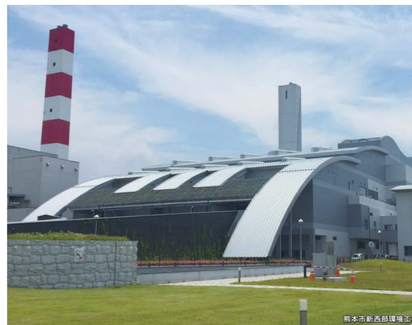
熊本市新西部環境工場
