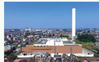
練馬清掃工場 (都市ごみ発電プラント)
