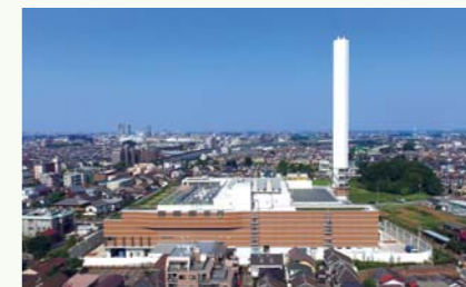
練馬清掃工場 (都市ごみ発電プラント)
