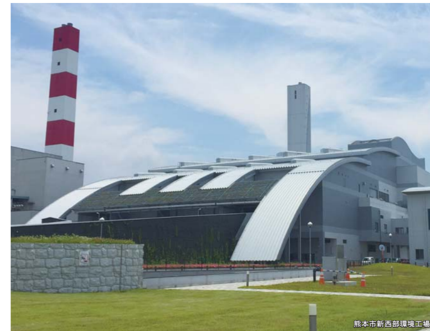
熊本市新西部環境工場
