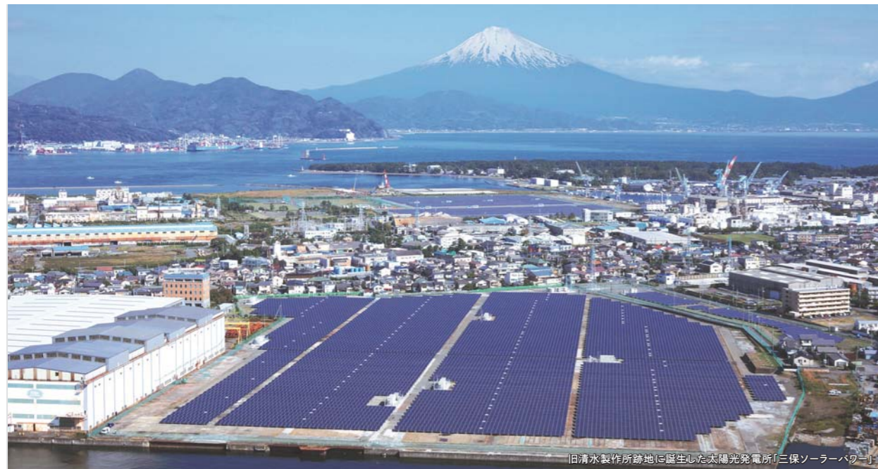
旧清水製作所跡地に誕生した太陽光発電所「三保ソーラーパーク」
