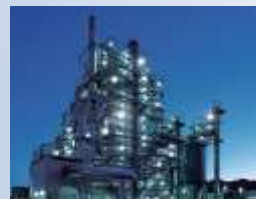
バイオマス発電設備
