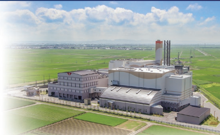
▲「BRA-ING®」を導入した新田清掃センター（新潟県）
