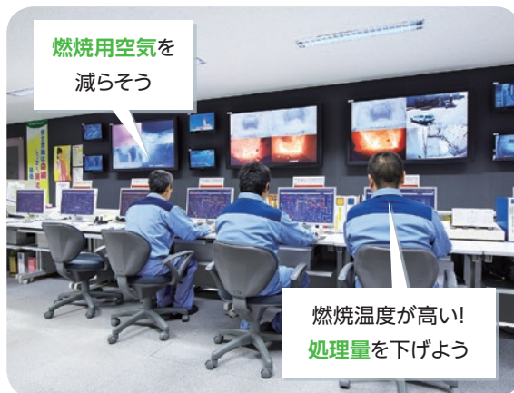
▲運転員による燃焼改善操作
