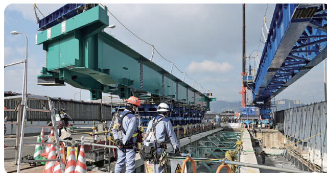
▲新桁への更新工事
