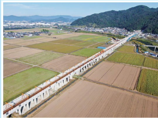
▲ 北陸新幹線金沢～敦賀間延伸工事(2024年3月延伸開業予定)
