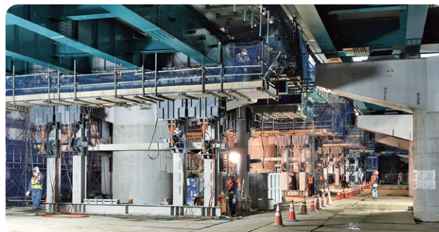
▲ジャッキアップ工法による新桁架設の様子
