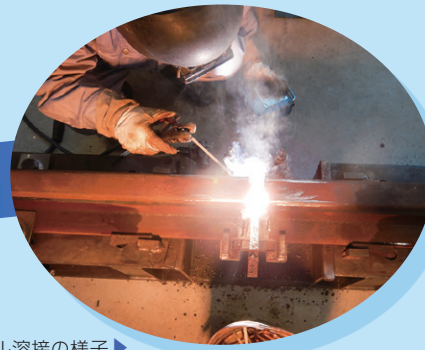
レール溶接の様子▶
