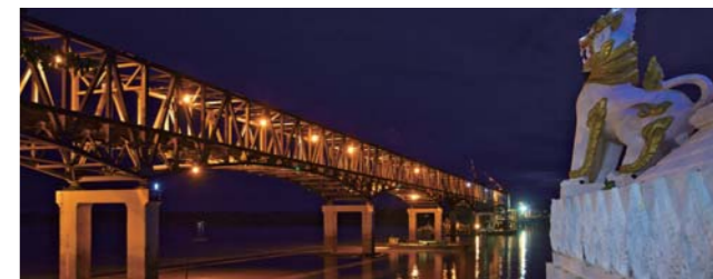
▲2013年5月に完成した「マロン橋」
