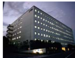
LED照明に切り替えた鶴見製作所のオフィス
