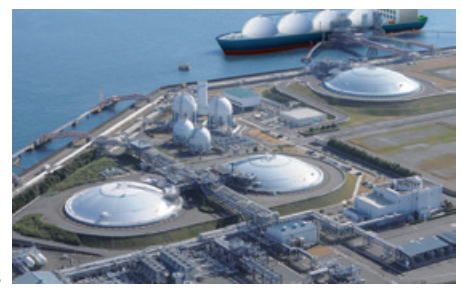
袖師LNG基地
