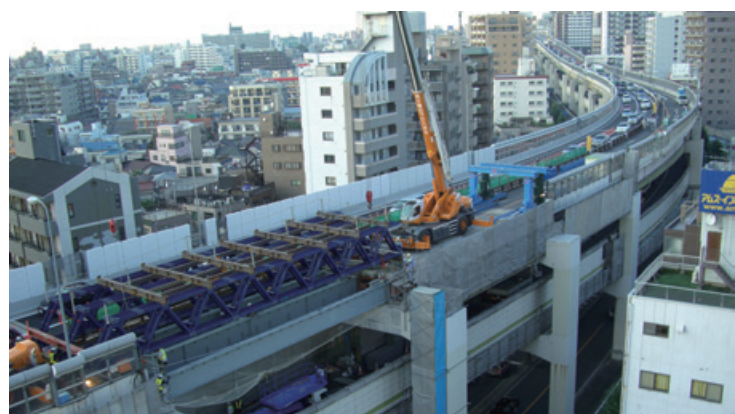
首都高速道路5号線 災害復旧架替工事
