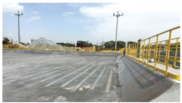
蒸気エージング設備(京浜地区)
