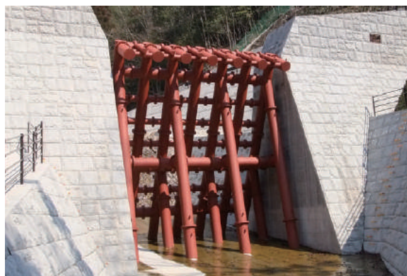
鋼製透過型砂防堰堤
