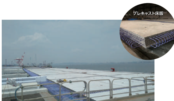
高炉スラグ細骨材を用いた栈橋のプレキャスト床版
