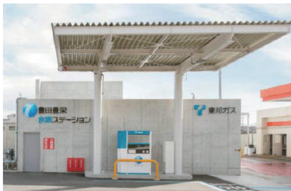
豊栄水素ステーション外観
