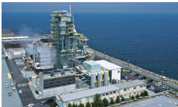
バイオマス発電プラント
