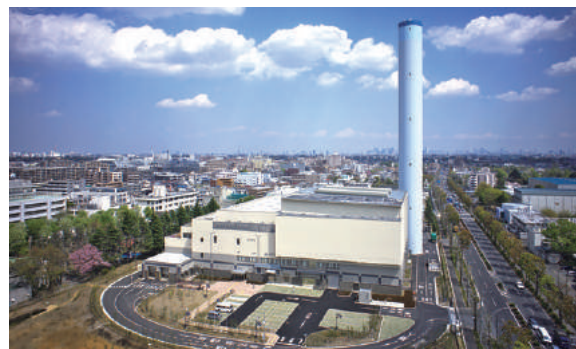
廃棄物発電プラント
