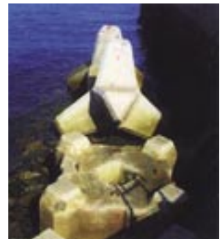
製鋼スラグを利用した消波ブロック
