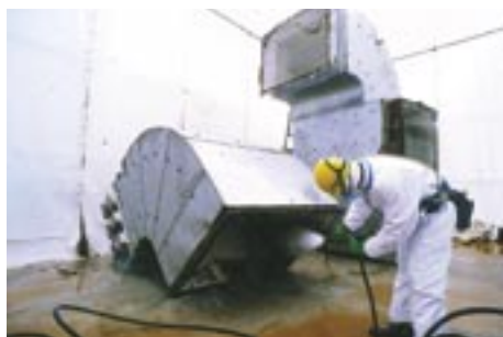
付着物の高圧水洗浄除去作業
