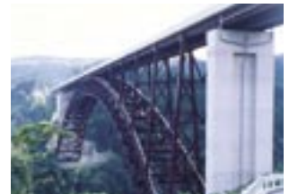
耐候性鋼を用いた奥阿蘇大橋
