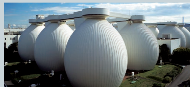
北部汚泥資源化センター(神奈川県横浜市)
