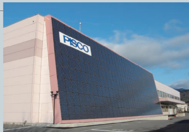
ソーラーパネルの施工例((株)日本ビスコ 伊奈第二工場)
