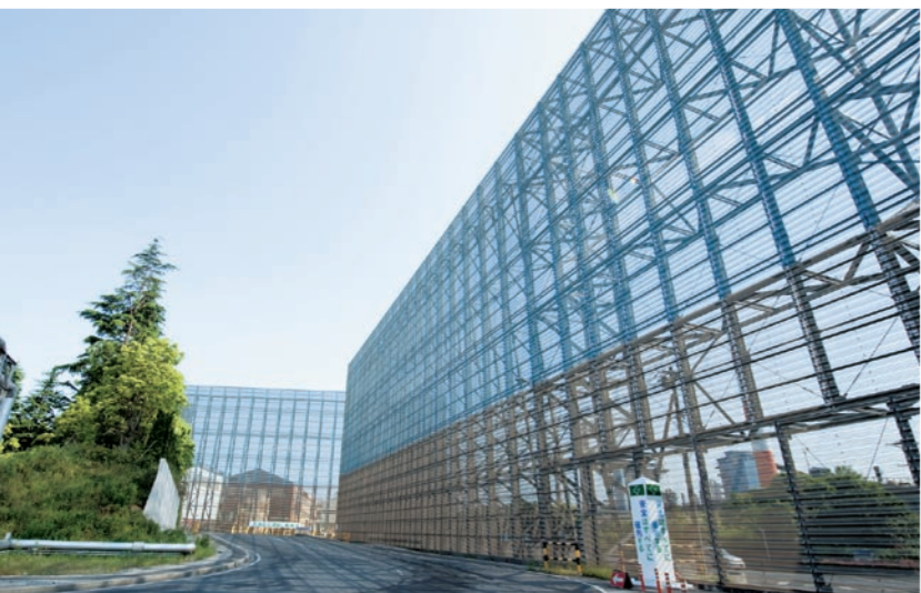
防じんフェンス:東日本製鉄所(千葉地区)の例
