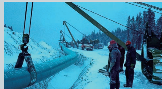
敷設中のパイプライン
