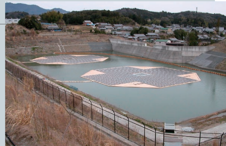
三重県亀山市の雨水調整池に設置された太陽光発電システム
