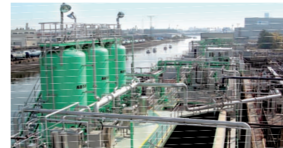
排水処理設備:東日本製鉄所(千葉地区)排水中窒素処理設備の例
