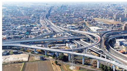
名古屋第二環状自動車道 名古屋西JCT
