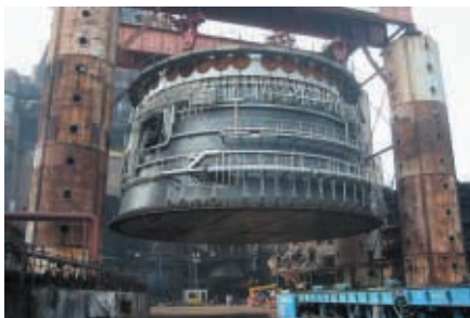
◆架構につり上げられた新しい炉体のブロック
