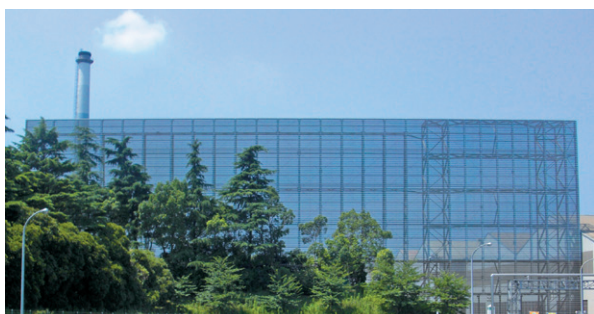
防じんフェンス(ハーバースクリーン 東日本製鉄所千葉地区)
