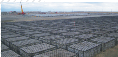
鹿島港防波堤に使われた鉄鋼スラグ水と固化体ラグーンマット®
