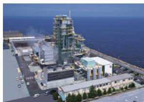
バイオマス発電所
