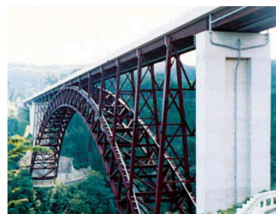
耐候性鋼が使用された橋梁
