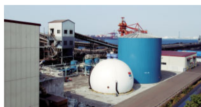
ビガダン方式バイオガスシステム
