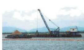
中海浄化覆砂工事
