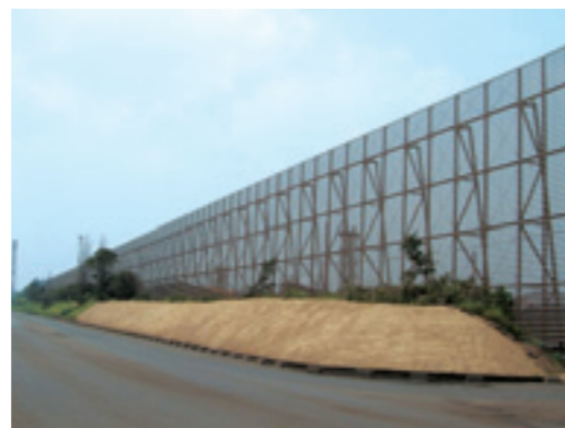
西日本製鉄所(福山地区)防じんフェンス
