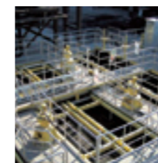
凝集沈殿池(新設)
