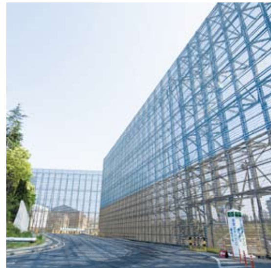
防じんフェンス:東日本製鉄所(千葉地区)の例
