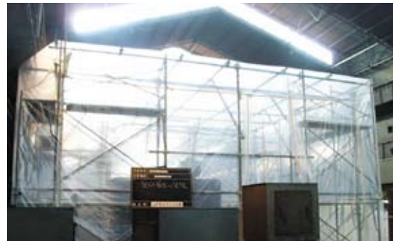
大型機器の抜油試験
