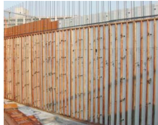
NFボード®使用の工事現場
