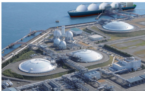
LNG base in Sodeshi, Japan
