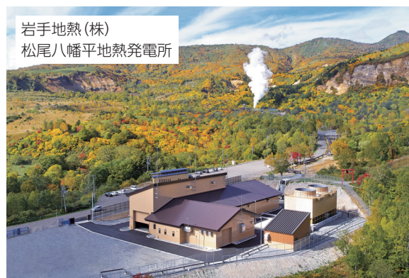
地熱発電プラント
