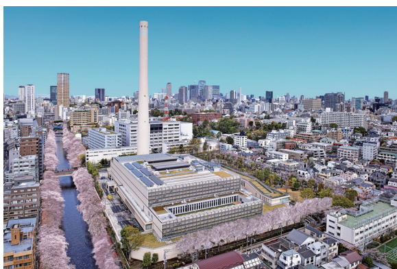
廃棄物発電プラント
