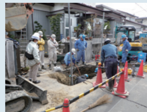
震災直後から仙台市内全域のガス管路の調査・補修に対応
