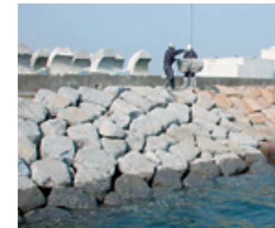
マリンロック(港湾修繕工事)
