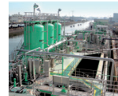
排水処理設備:東日本製鉄所(千葉地区)排水中窒素処理設備の例
