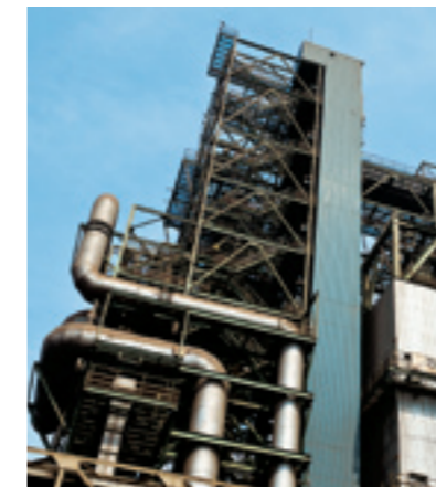
焼結炉排ガス処理設備・西日本製鉄所(福山地区)活性コークス方式の例
