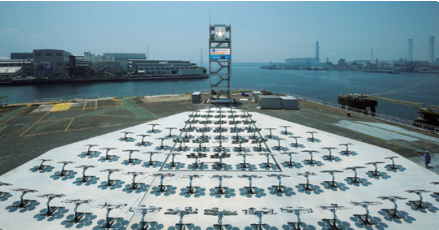
太陽エネルギー発電システムの実証プラント(鶴見製作所)
