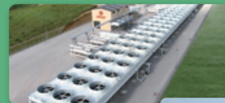
低温蒸気や熱水から電力をつくる地熱バイナリー発電 (JFEエンジニアリング・P43)
