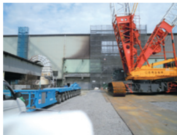
復旧工事・屋根撤去(JFE条鋼仙台製造所)
