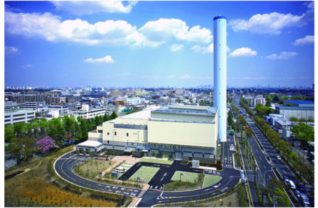
廃棄物発電プラント
