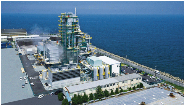
バイオマス発電プラント
