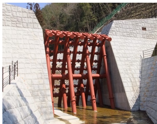
鋼製砂防堰堤
