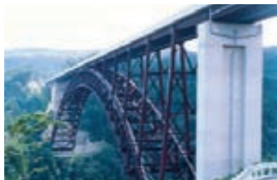
耐候性鋼を用いた奥阿蘇大橋
