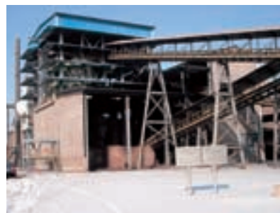
クロム粉鉱石ペレットの焼成キルン
