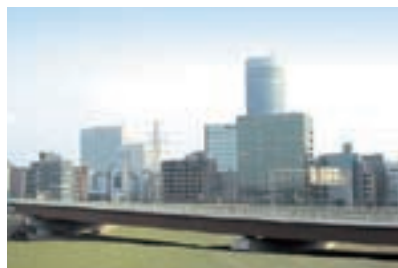
さび安定化処理剤使用例
