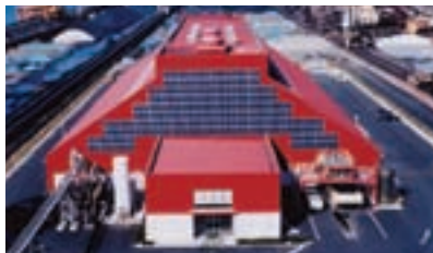
サーモセレクト方式ガス化改質炉
