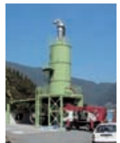
流木リサイクルプラント
