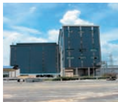
製紙スラッジ焼却廃熱回収設備
