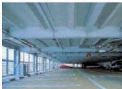
耐火鋼材を使用した駐車場
