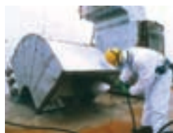
付着物の高圧水洗浄除去作業
