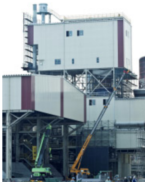
現在、シャフト炉を建設中です(全高=50m)。
