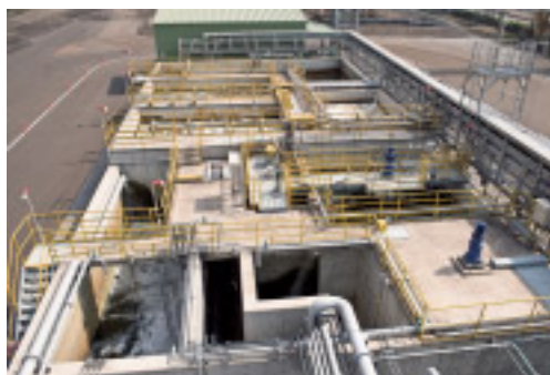
排水処理設備:西日本製鉄所(福山地区)生物処理方式の例
