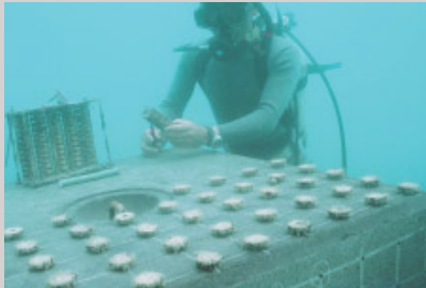
サンゴの幼生の付いた着床具をマリブロック®に設置
