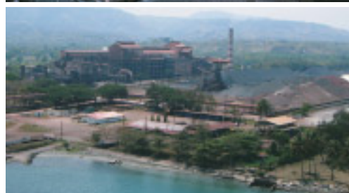
PSCでは排熱回収設備を建設中です。
