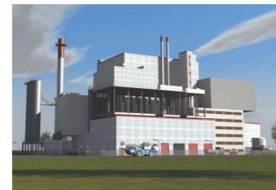
SPSH社傘下のバウムガルテ・ボイラ・システムズ社が手がけた独シュレムベルグ・廃棄物発電プラント(2013、年処理量960t/日)
