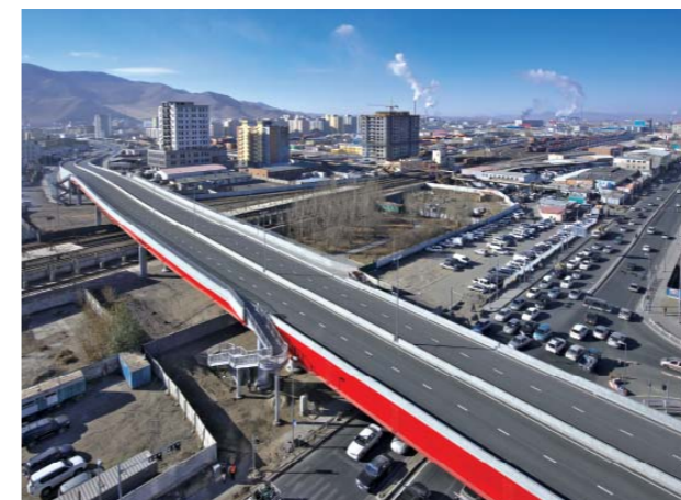
モンゴル最大の鋼製橋梁「太陽橋」
