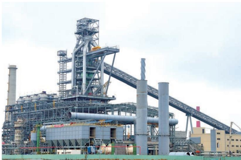
一貫製鉄所の象徴である高炉
