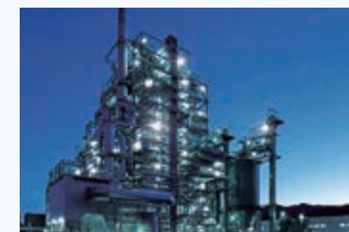
バイオマス発電設備
