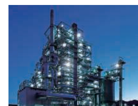
バイオマス発電設備
