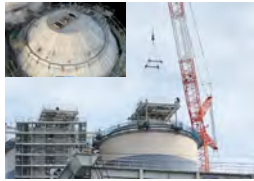
ドローンによる高精度3D計測結果を用いた高所作業低減実施例
