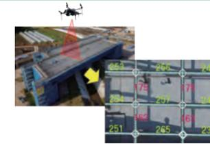
橋梁の施工現場における配筋検査について、ドローンによる写真撮影と画像認識AIを活用して配筋検査を自動化する世界初のシステムを開発。計測時間と人員の効率化に寄与
