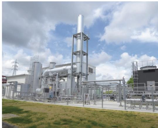
ハウス食品静岡工場に設置したガスコージェネレーションシステム
