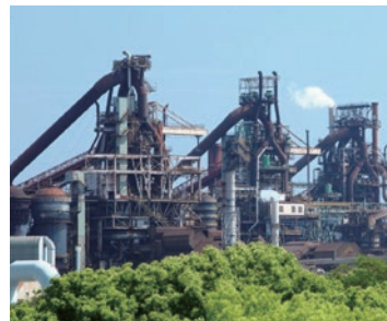
西日本製鉄所（福山地区）の高炉群
