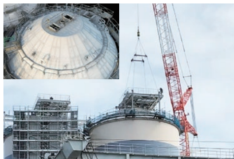
ドローンによる高精度3D計測結果を用いた高所作業低減（JFEエンジニアリング）
