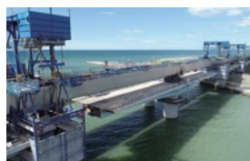
インフラ長寿命化（橋梁改築）
