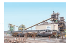
カーボンリサイクル試験高炉 (NEDO 製鉄プロセスにおける 水素活用プロジェクト (GREINS))
