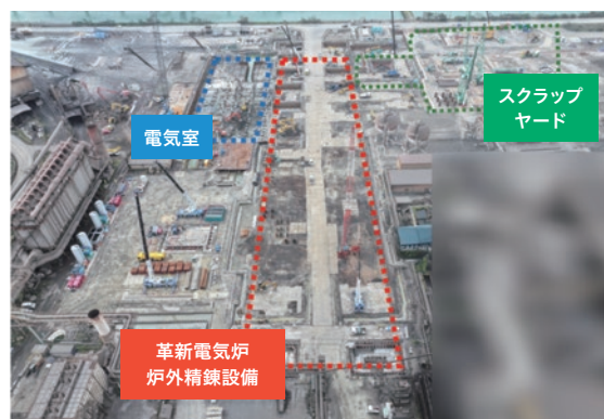
工事の様子（2026年4月）
