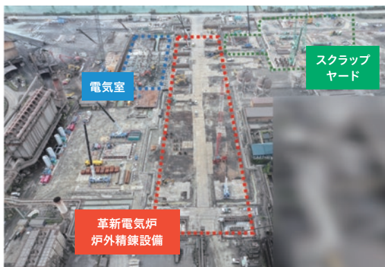
工事の様子（2026年4月）
