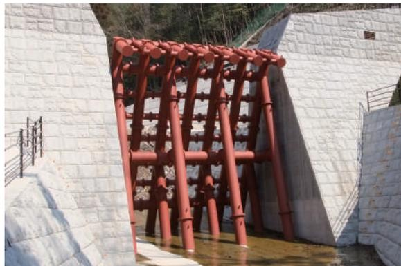
鋼製透過型砂防堰堤
