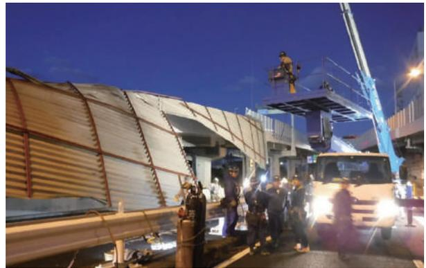
2019年台風19号による首都高横羽線緊急復旧(左：被害の状況 右：復旧作業)
