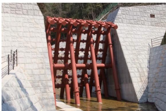
鋼製透過型砂防堰堤
