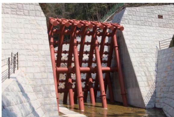
鋼製透過型砂防堰堤
