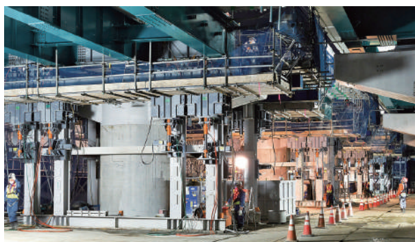
ジャッキアップ工法による新桁架設の様子
