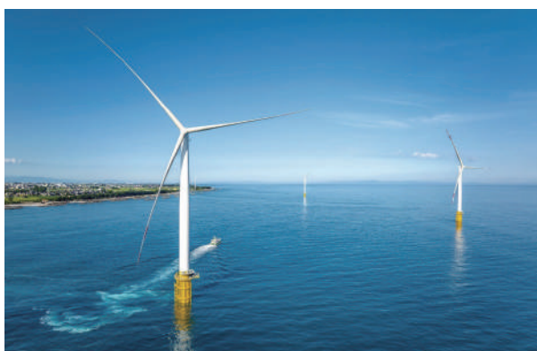
入善洋上風力発電所 (写真提供：(株)ウェンティ・ジャパン)
