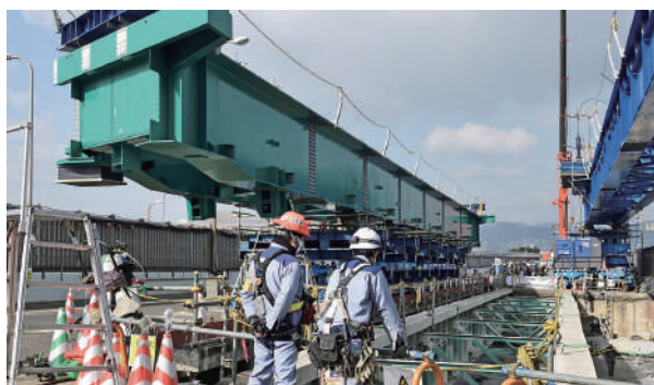
新桁への更新工事
