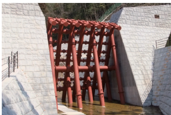
鋼製透過型砂防堰堤
