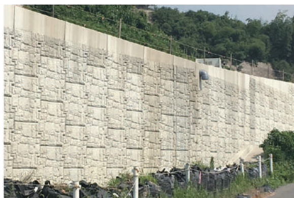
国道3号線（熊本県）での施工実績
