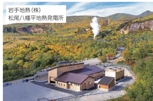
地熱発電プラント
