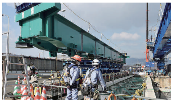
新桁への更新工事
