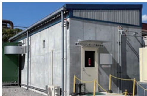
■ 画像1：液体アンモニア応力腐食割れ試験建屋
