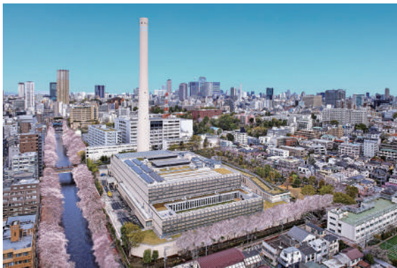
廃棄物発電プラント
