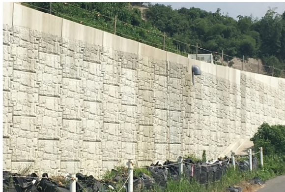
国道3号線(熊本県)での施工実績
