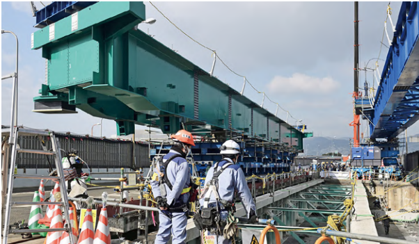
新桁への更新工事
