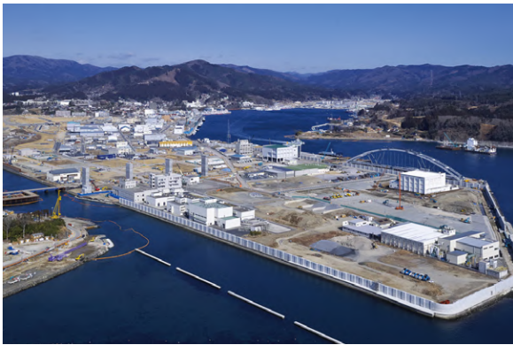
ハイブリッド防潮堤
