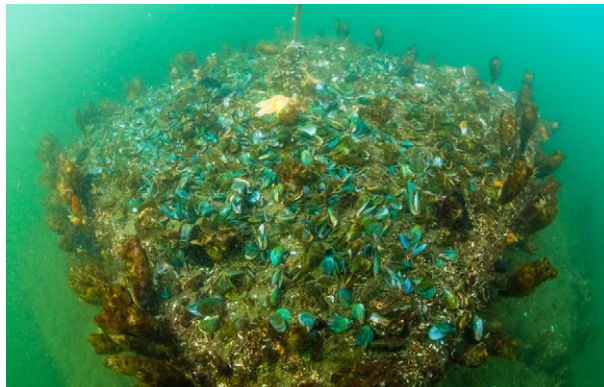
二枚貝がびっしり着生したマリンブロック®（山下公園前海域）
