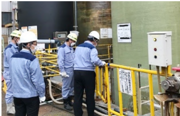
国内グループ会社の現場監査状況
