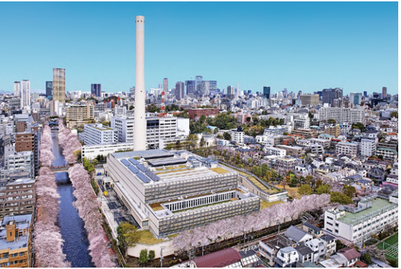
廃棄物発電プラント
