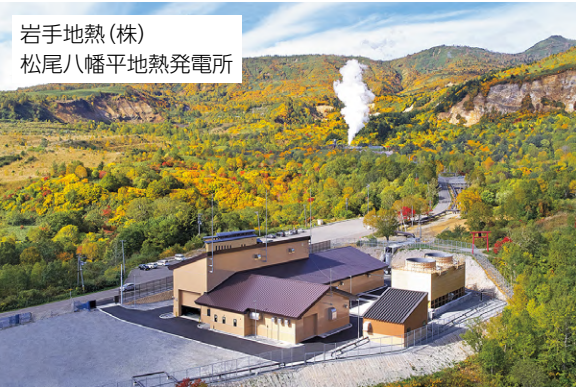
地熱発電プラント
