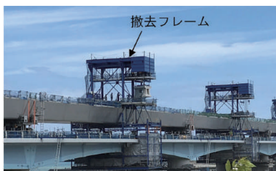
現地施工状況
