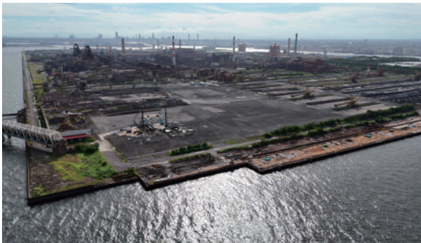
水素基地建設開始(2025年5月)
