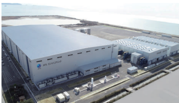
笠岡モノパイル製作所 全景
