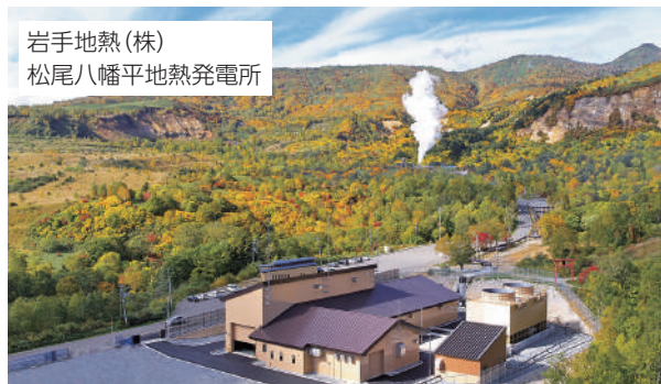
地熱発電プラント
