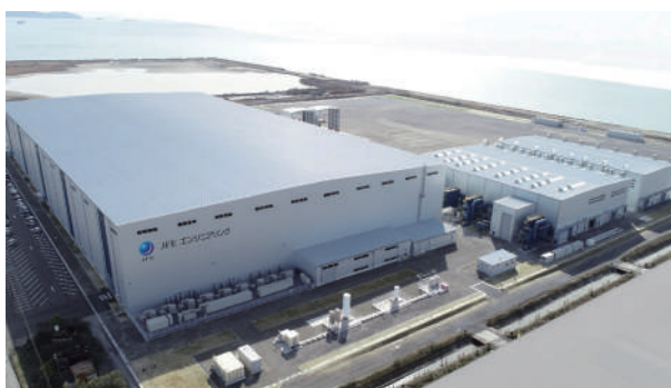
笠岡モノパイル製作所 全景
